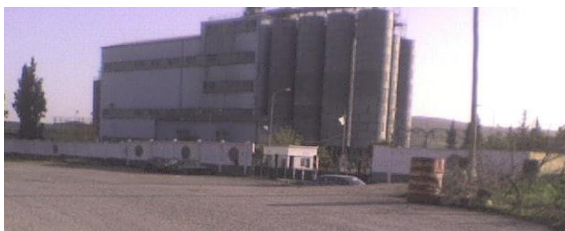
El Harrouch - uno dei Mangimifici costruiti per O.N.A.B. in Algeria
