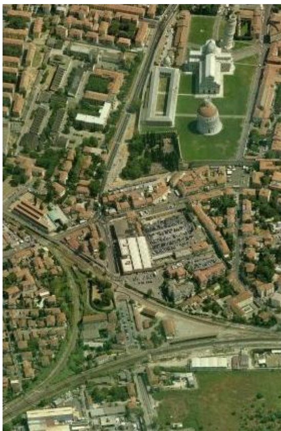
Pisa – Sottopassi ferroviari di Via Pietrasantina e Delle Cascine
