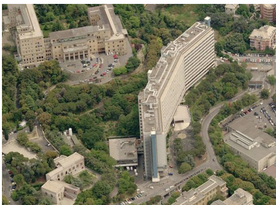
Genova – Laboratori centralizzati Ospedale S. Martino
