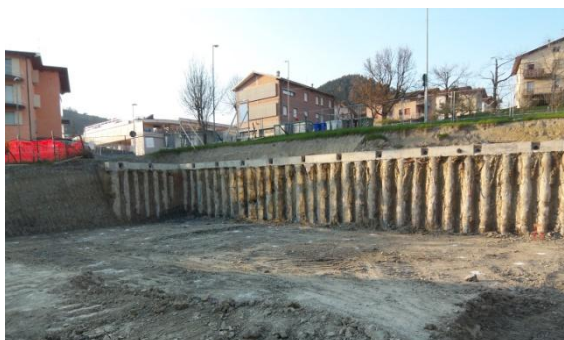
Castelnovo ne' Monti (RE) – Autorimessa Protezione Civile
