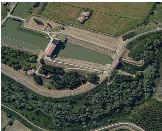
Moglia (MN) – Impianto idrovoro “Le Mondine”
