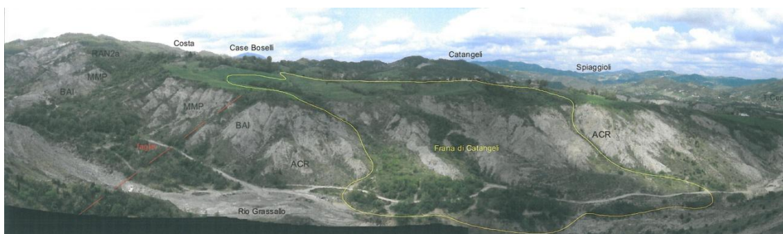
Catangeli (PR) – salvaguardia dell'abitato dallo scoscendimento del versante
