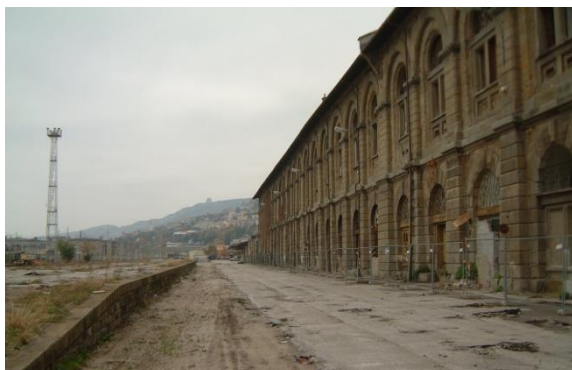
Trieste – Restauro dei Magazzini Silos
