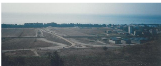
Catanzaro Lido – uno dei sottopassi ferroviari realizzati in Calabria e Campania
