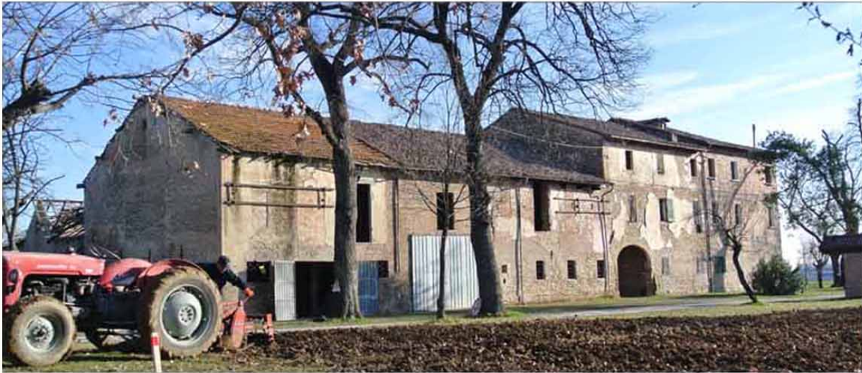
prima dei lavori
