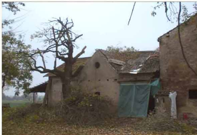
prima dei lavori
